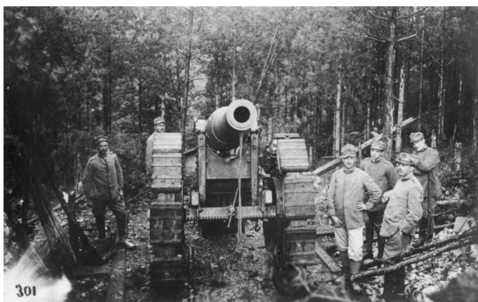
CANNONE DA 149/35 MOD. 1901 CON CINGOLI "BONAGENTE"
