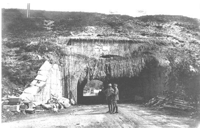
LO SBOCCO MERIDIONALE DEL SOTTOPASSO FERROVIARIO DI PIEDIMONTE DOPO L'ENTRATA DELLE TRUPPE ITALIANE A GORIZIA
