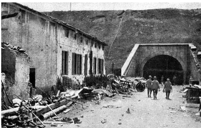
LO SBOCCO SETTENTRIONALE DEL SOTTOPASSO FERROVIARIO DI PIEDIMONTE
